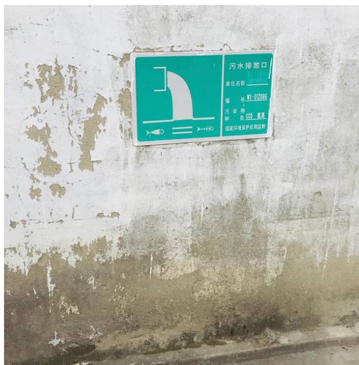
图 9-1 废水排口标识
