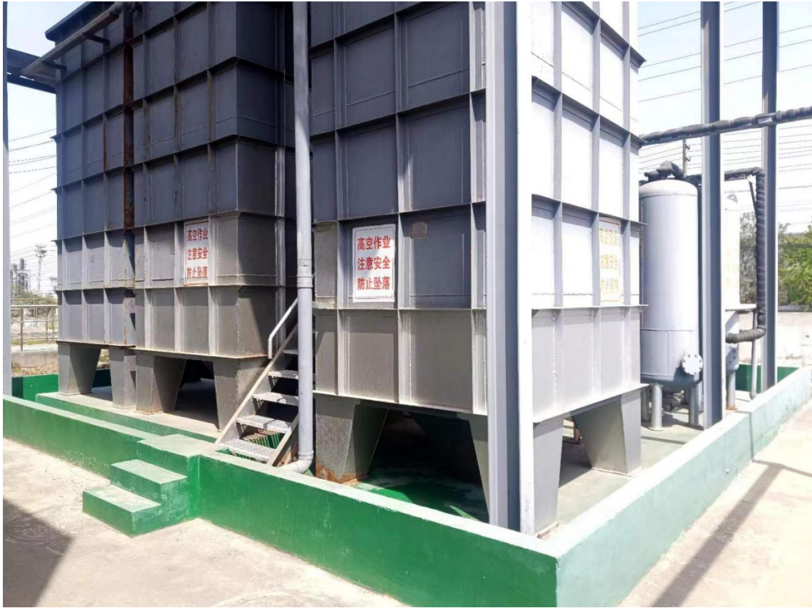
图4.1-3渗滤液处理站排查图
